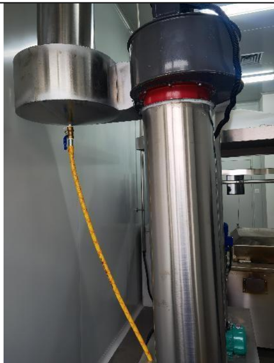
锻药间水浴除尘器
